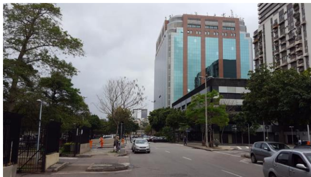
Figura 22 - Rua Pinto de Azevedo. Prédios comerciais
