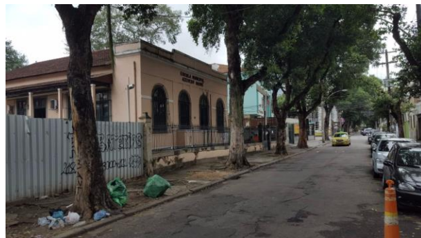
Figura 39 - Escola Municipal Azevedo Sodré
