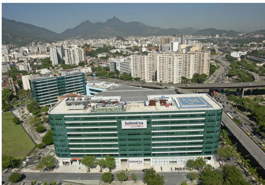
Figura 3 - Imagem do prédio com destaque para o Heliponto (Fonte Google Imagens)
